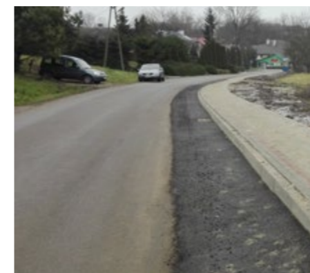
Fot. Chodnik przy drodze powiatowej w Nowosielcach
