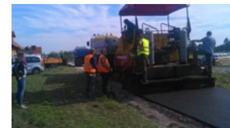
Fot. Układanie masy asfaltowej na drodze w Urzejowicach
