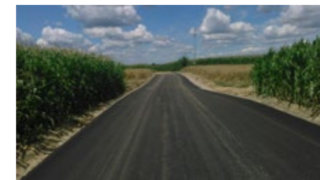
Fot. Droga Grzeska - Przeworsk
