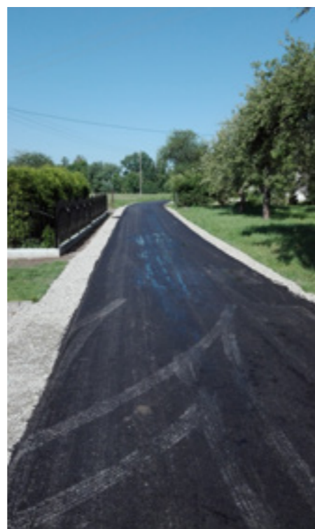
Fot. Zmodernizowany odcinek drogi w Świętoniowej
