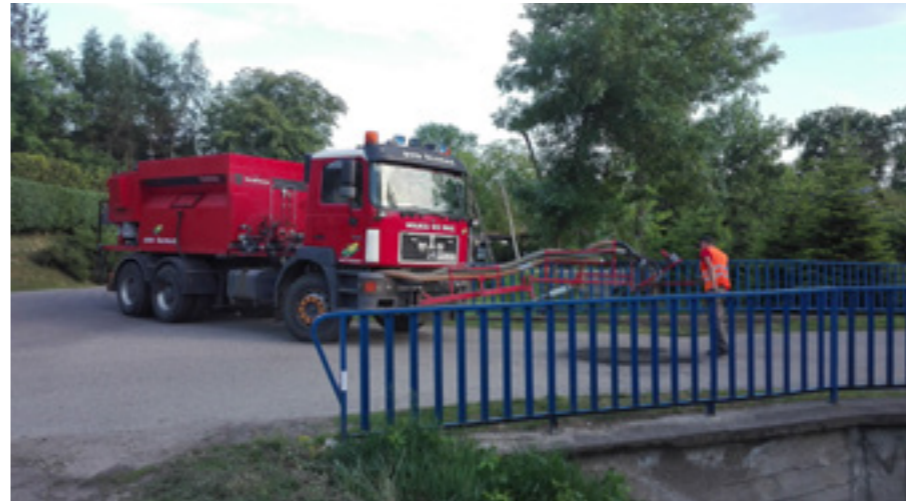
Fot. Prace remontowe na drodze
