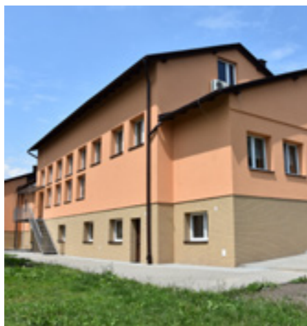
Fot. WDK po remoncie
