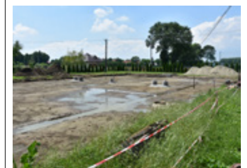
Fot. Prace na boisku
