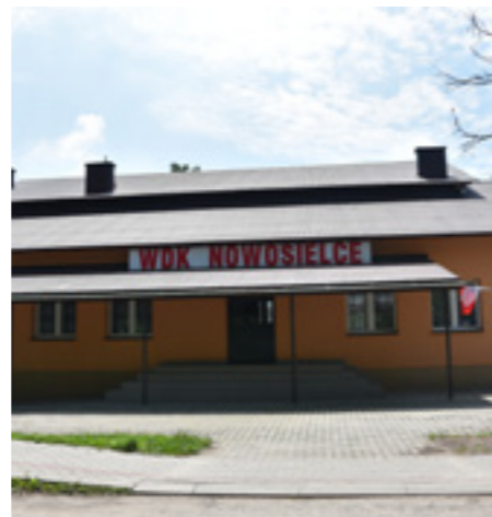
Fot. WDK po remoncie
