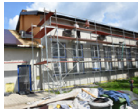
Fot. Prace remontowe w Ujeznej
