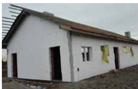
Fot. Powstający budynek szatni w Gorliczynie.
