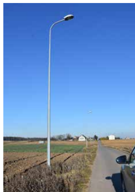
Fot. Oświetlenie uliczne.
