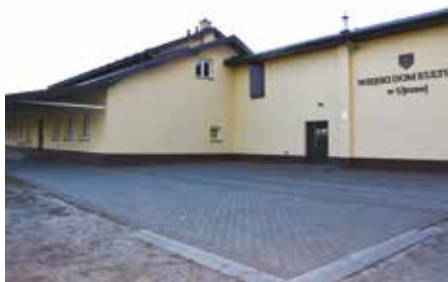
Fot. Front budynku po remoncie.
