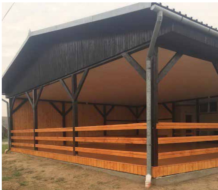
Fot. Podłoga taneczna po remoncie.
