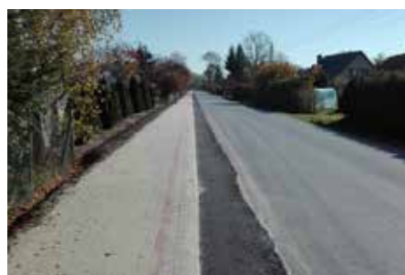
Fot. Budowa chodnika w Nowosielcach.
