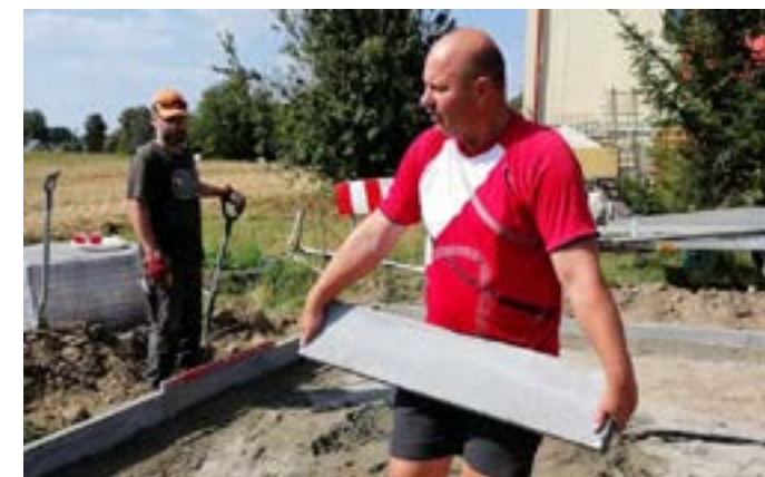
Zdj. Pracę przy tworzeniu „przystani”
