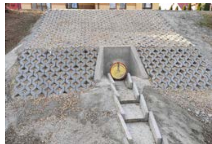
Zdj. Wylot kanalizacji deszczowej
