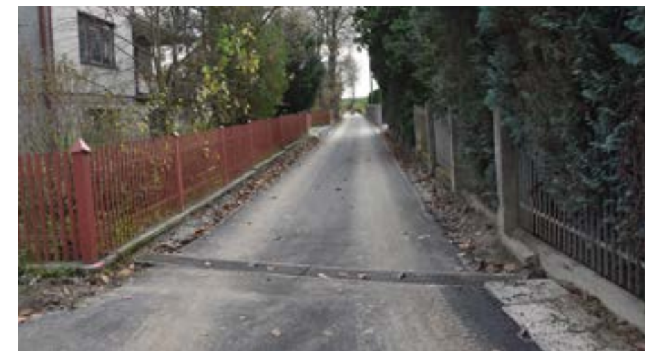
Zdj. Droga w Ujeznej
