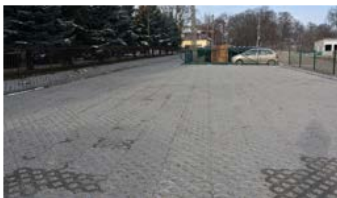
Zdj. Nowy parking przy szkole w Urzejowicach
