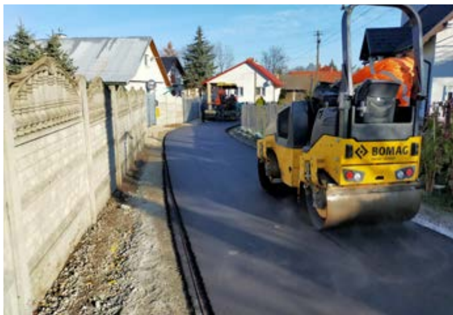
Zdj. Prace na drodze w Urzejowicach
