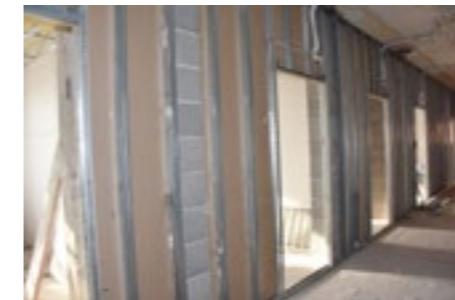
Zdj. Budynek urzędu wewnątrz w trakcie remontu
