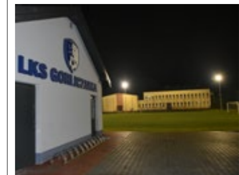
Zdj. Oświetlenie boiska sportowego w Gorliczynie
