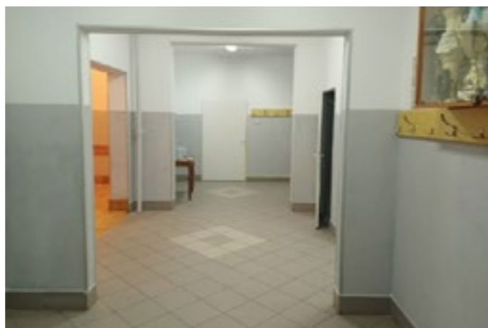
Zdj. Budynek WDK w Gorliczynie po remoncie
