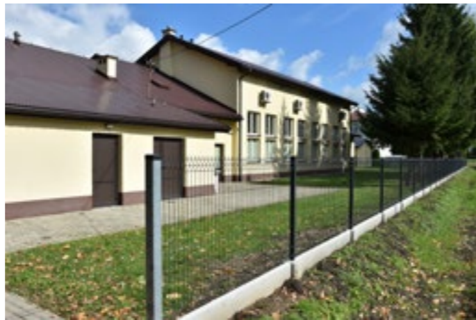
Zdj. Nowe ogrodzenie przy WDK w Ujeznej
