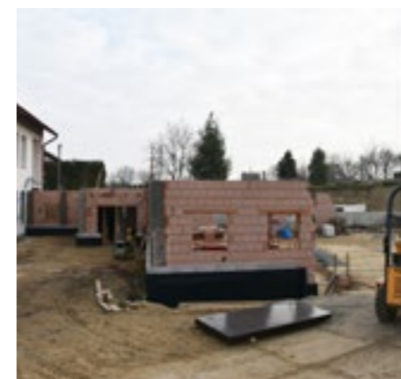
Zdj. Prace przy budowie sali gimnastycznej w Mirocinie
