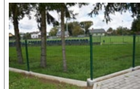
Zdj. Nowe ogrodzenie boiska sportowego w Grzęsce
