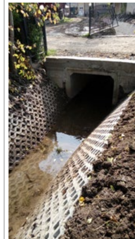
Zdj. Przebudowany rów melioracyjny w Urzejowicach
