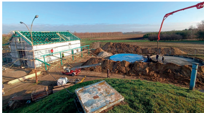
Budynek Stacji Uzdatniania Wody i fundamenty pod zbiornik wodny
