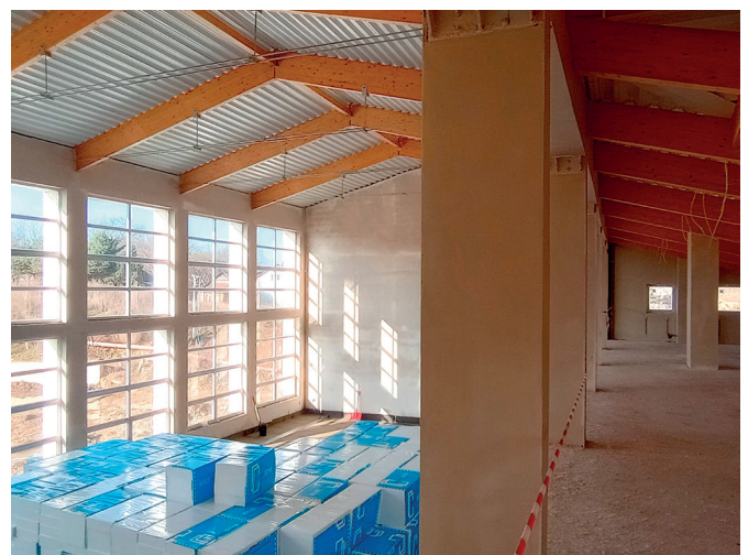
Prace wewnątrz budynku
