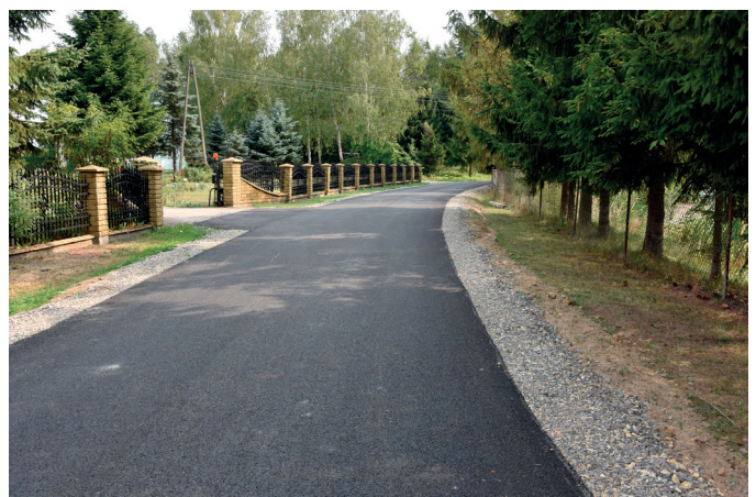
Przebudowana droga gminna w Grzęsce w ramach funduszu sołeckiego
