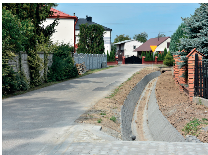
Umocnienie rowu przy drodze gminnej w Ujeznej
