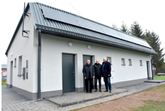
Szatnia po remoncie
