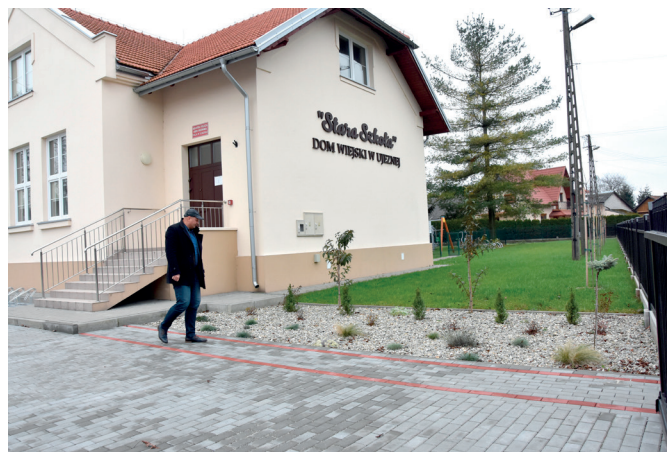
Plac przed budynkiem „Starej szkole” w nowej odsłonie
