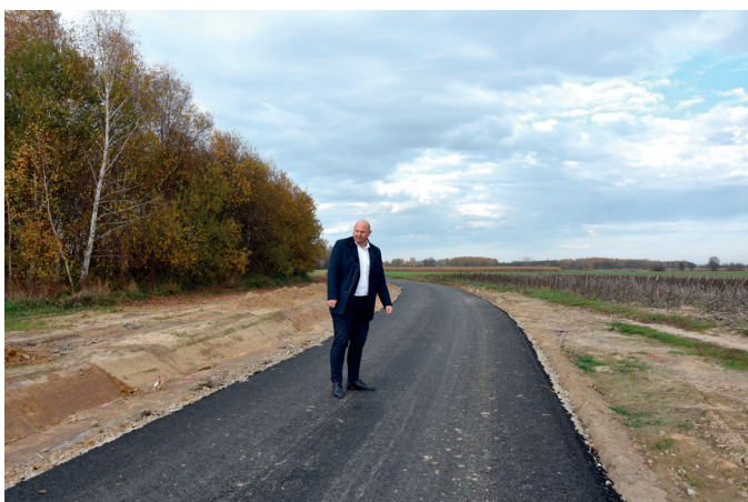
Zmodernizowana droga gminna Rozbórz – Gorliczyna
