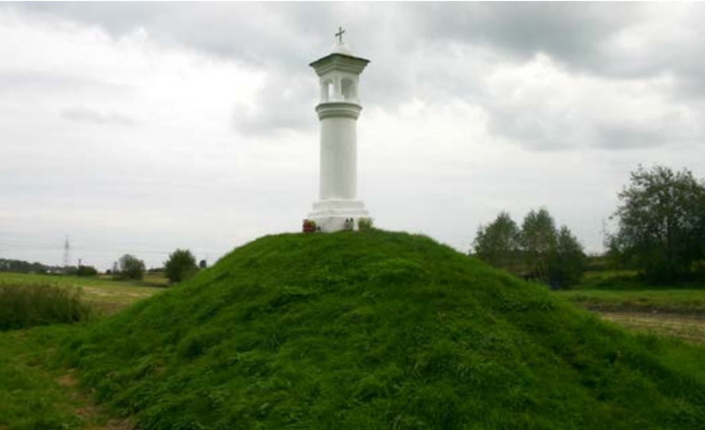
Fot. Kapliczka na kopcu przy ul. Tatarskiej w Przeworsku, fot. Ryszard Kwolek, 2010.
