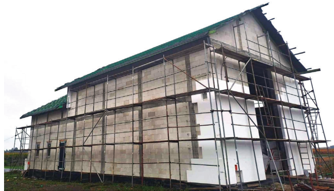
Budowa Stacji Uzdatniania Wody w Urzejowicach
