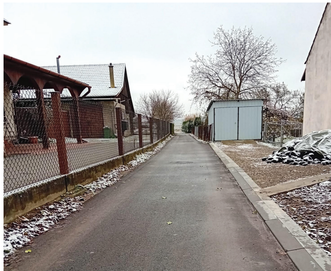
Droga gminna w Urzejowicach
