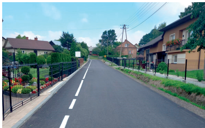
Droga gminna nr 110820R w Studzianie
