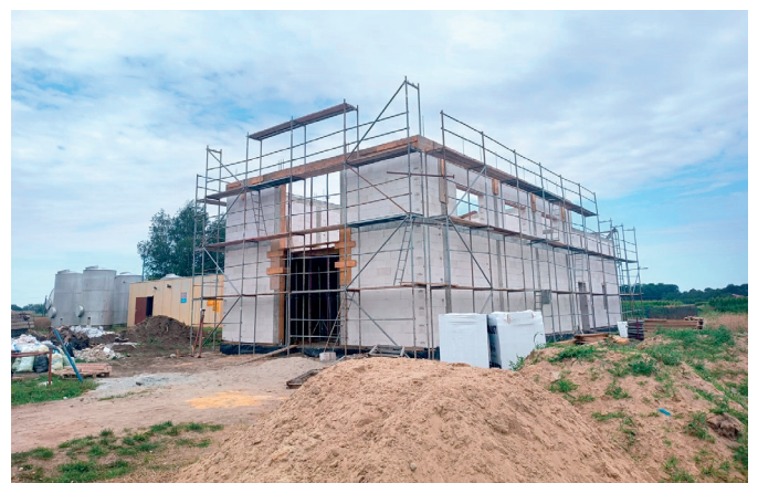
Budowa SUW w Urzejowicach
