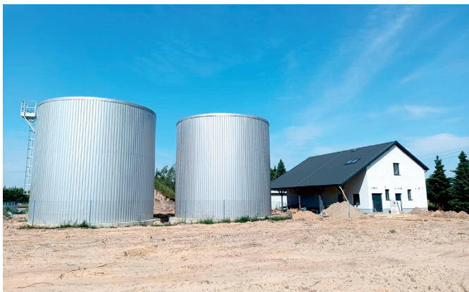
Budowa SUW w Świętoniowej
