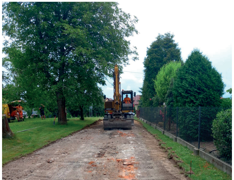
Remont drogi gminnej w Rozborzu
